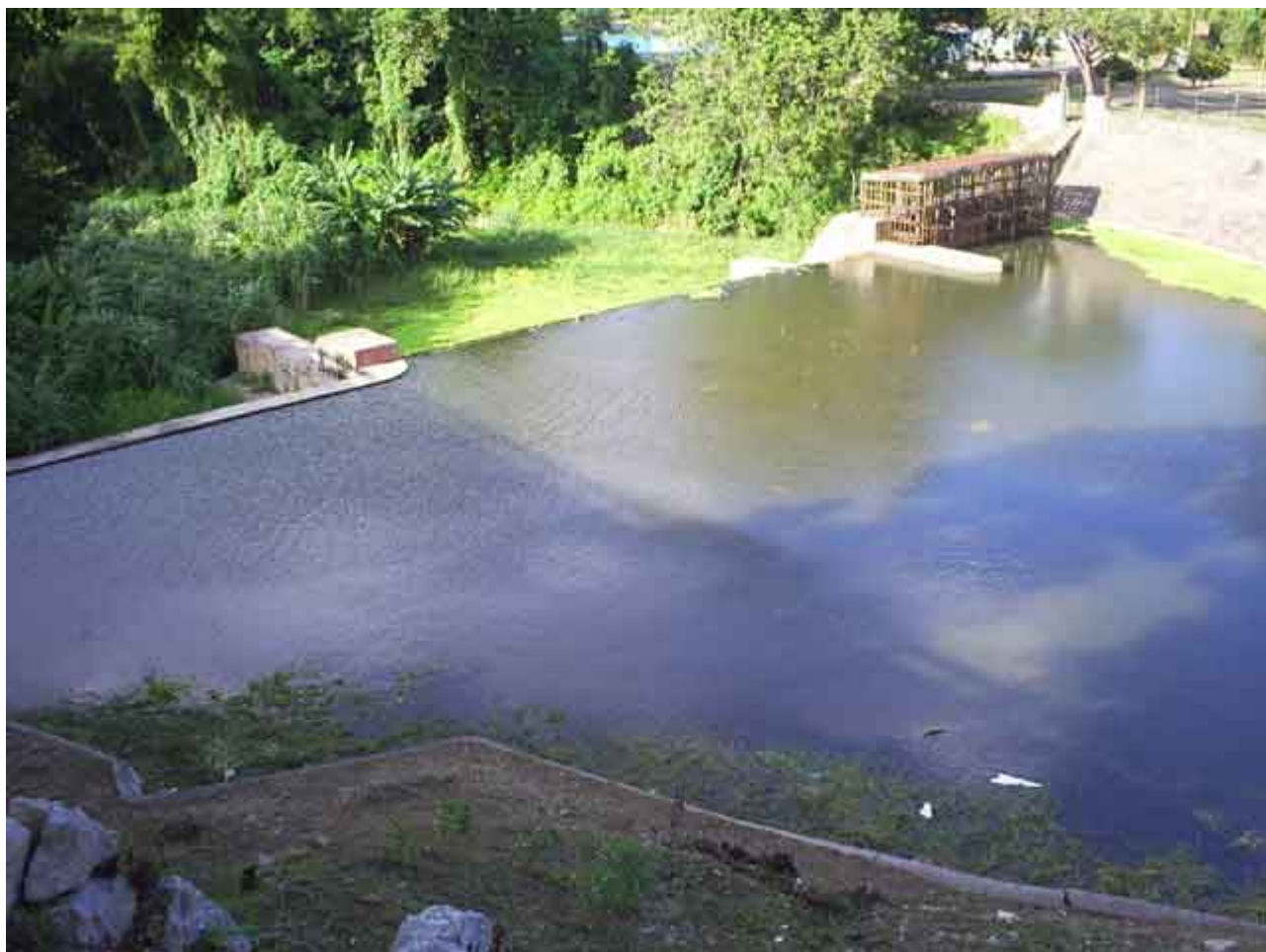
Represa de hormigón construida en 1949, río Almendares, La Habana, 13 de octubre de 2012.
